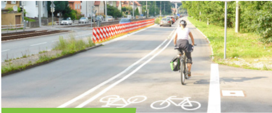
Die Böblinger Straße nach dem Ausbau zur Hauptroute.
